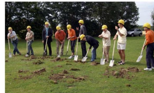
Im Juli 2009 erfolgte der Spatenstich durch die Mitglieder der Planungsgruppe.
